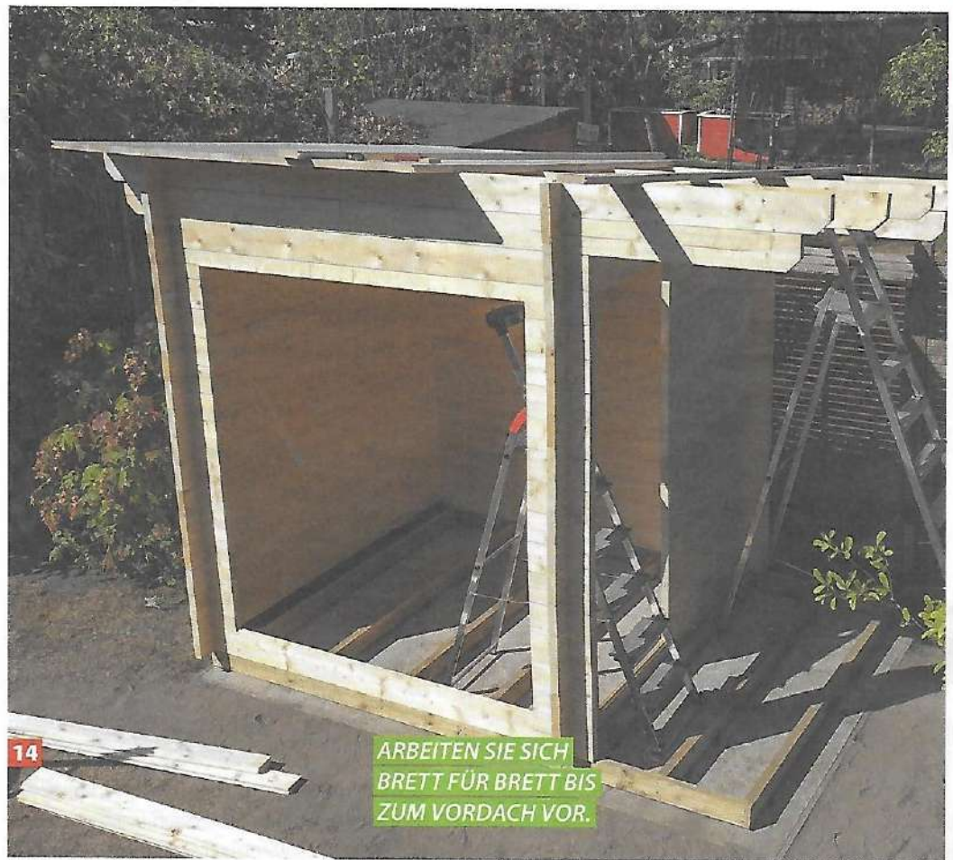
11 Hier sehen Sie die fertig eingesetzten Dachsparren. Sie ragen an der rechten Seite heraus und bilden das Vordach.
