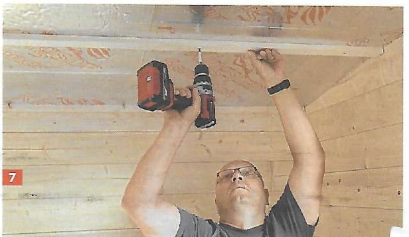
5 ... Platten zu und nageln sie an. Als Dampfbremse werden dann die Schlitzze zwischen den Dämmplatten mit ...
